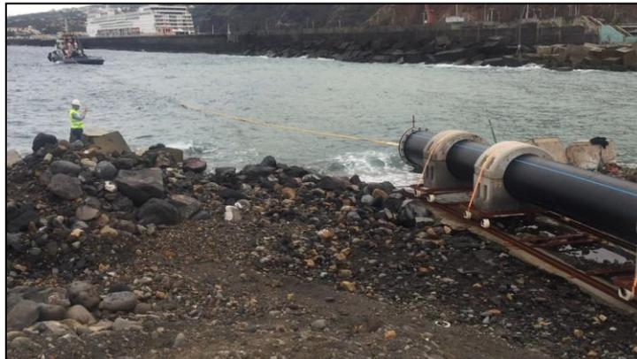
Una vez hundido el extremo a embridar, se procede a cerrar la llave de salida de aire del otro extremo y a retirar la tapa del extremo hundido, evidentemente, debe estar completamente hundido de forma que no pueda salir el aire porque se hundiría el tubo entero sin poder controlar su posición y de aquí que toda la operación deba hacerse con la marea llena.
