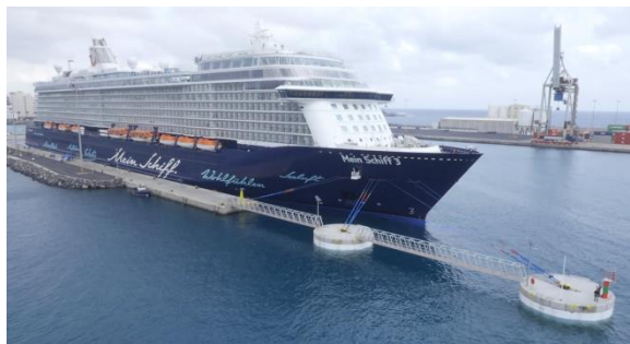
Figura 1. Duques de Alba de Materiales Compuesto en servicio. Puerto del Rosario (Fuerteventura)
