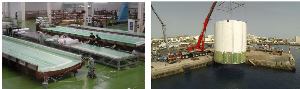
Figura 3. Fabricación de las piezas en planta (izqda.) y botadura del cajón ensamblado (dcha.)
