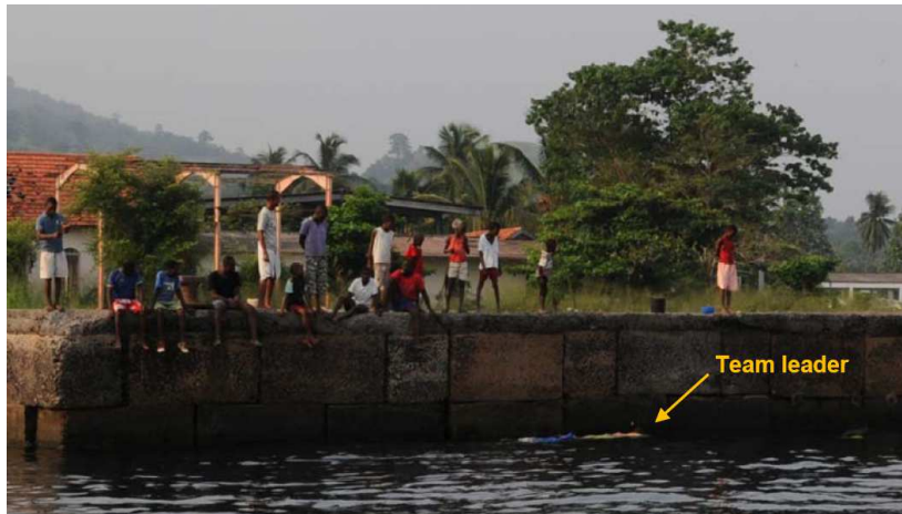
Figura 2. Inspección de un muelle existente
