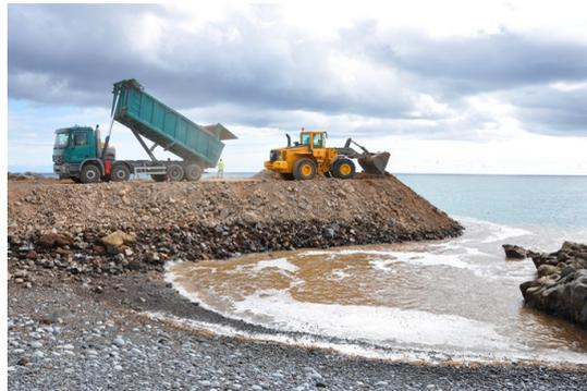
Figura 3. Avance de dique en talud
