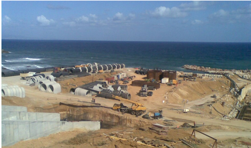
Figura 1: Ejecución obras marítimas
