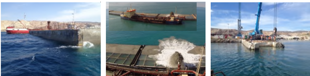
Figura 2. Diversos momentos de la ejecución de las obras.
