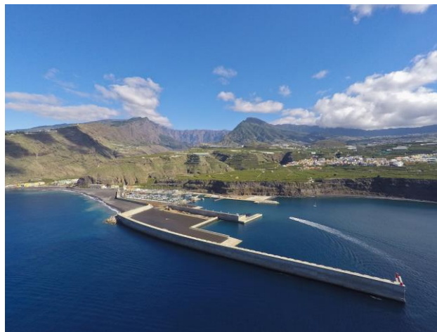
Figura 2. Panorámica a tierra del Puerto de Tzacorte
