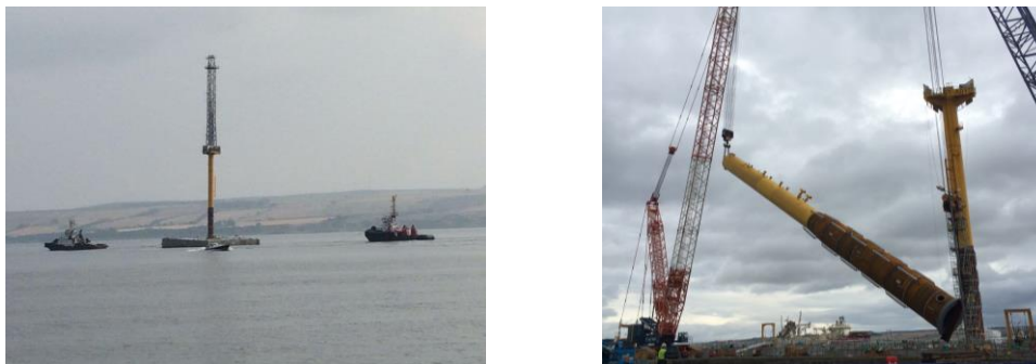
Figura 3. Remolque e instalación de estructuras a flote.
