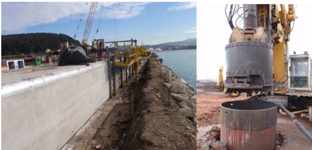
Figura 3. Imágenes de la ejecución de la obra
