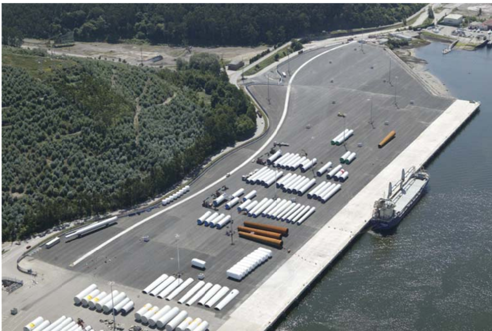
Figura 1. Vista de la obra finalizada
