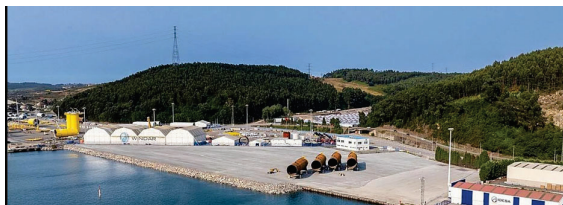
Fig. 4 Vista final de las obras. Fuente: Autoridad Portuaria
