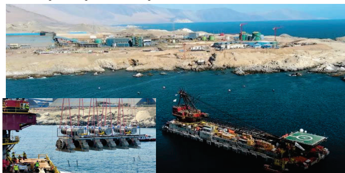
Fig. 1. Vista de la instalación de una rama de filtros pasivos y el equipo flotante utilizado.
