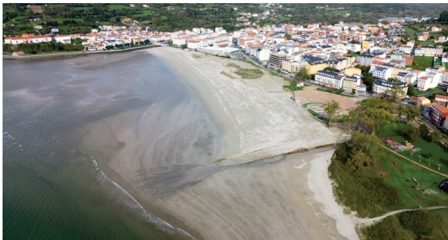
Fig. 1 Estado final de la playa de la Magdalena. Fuente: MITECO, (2025)
