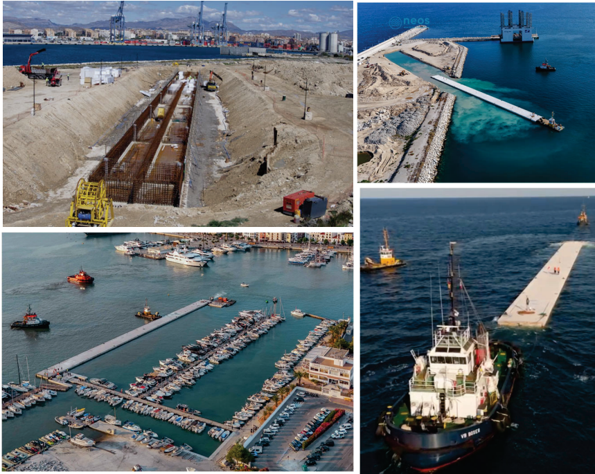
Fig. 1. Construcción, botadura, remolque y colocación del dique flotante
