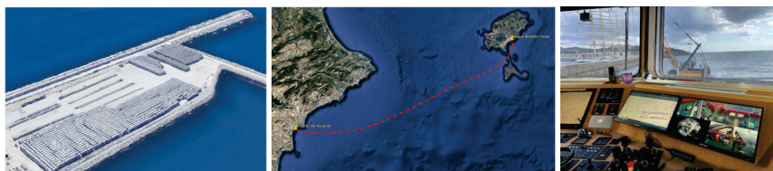
Fig. 2 Fabricación en el Puerto de Alicante (izda.), transporte Alicante-Ibiza (ctro.) y colocación de bloques en Ibiza (dcha.). Fuente: Google Earth y TYPSA
