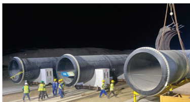
Fig. 1 Proceso de lastrado de una conducción de gran diámetro. Fuente: Acciona Agua
